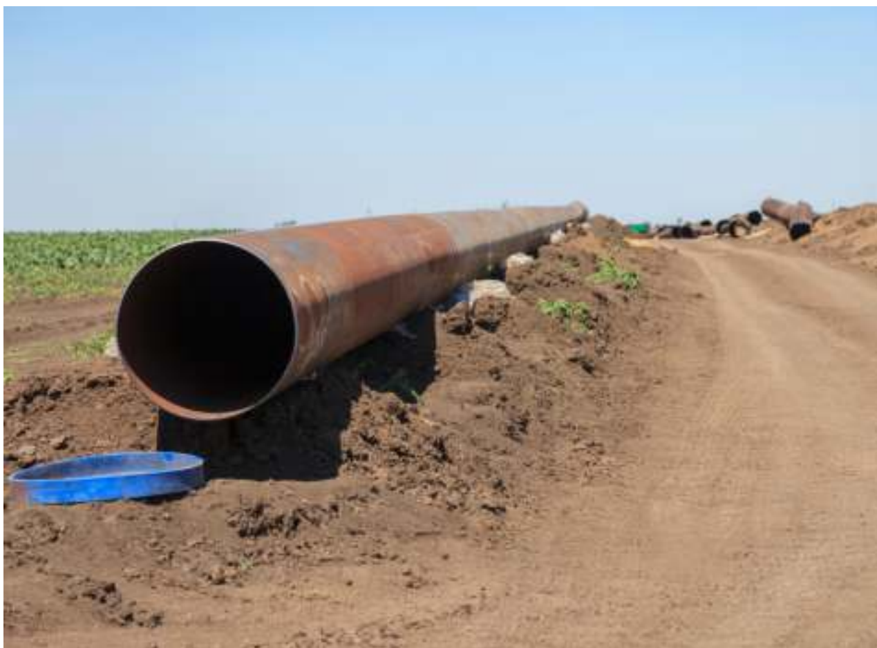
Gazoduc en construction, image d'illustration
